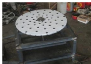
Gambar 4. Pemasangan poros, sekher, dan puli pada kerangka
