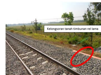
Gambar 2. Kelongsoran Tanah Timbunan
