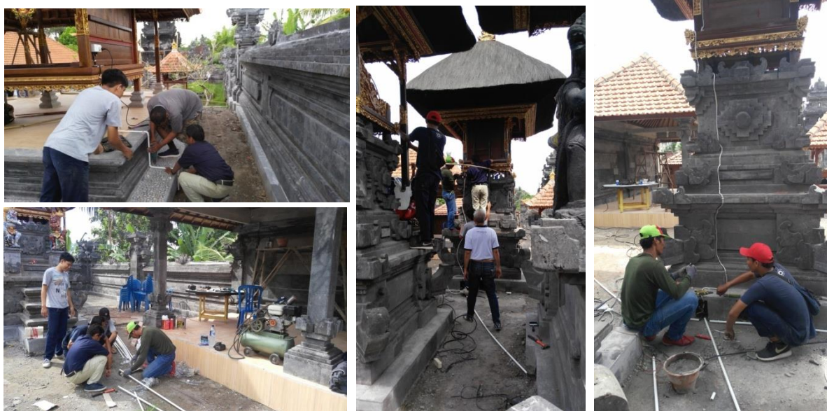
Gambar 1. Pemasangan instalasi listrik, pencahayaan dan air bersih.
