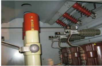
Gambar 10. Pemasangan PT dan CT
