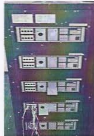
Gambar 6. Kubikel amplifier tegangan dan arus
