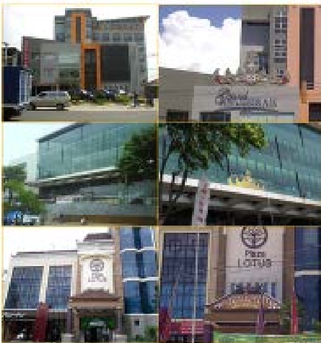
Gambar 6. Pemasangan Siger pada Fassade bangunan sebelum dan setelah keluarnya peraturan (sumber: Olahan Pribadi).
