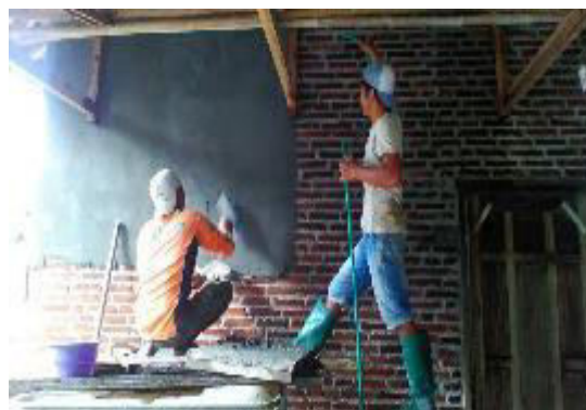
Gambar 1. Perbaikan sanitasi pada ruang produksi nata de coco
