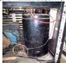
Gambar 2.3 kompresor hermetik ( Lab.Refrigerasi Politeknik Sekayu )
