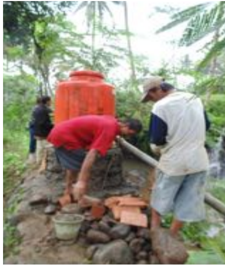
Gambar 7. Perbaikan instalasi pompa hidram.
