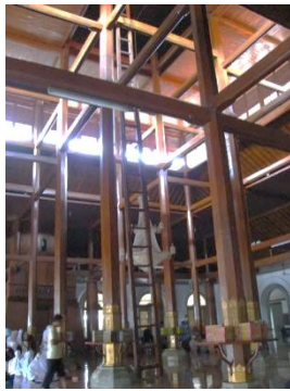
Gambar 2. Ruang dalam masjid Ampel lama yang didominasi unsur struktur kayu
