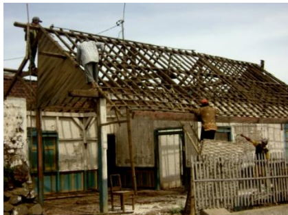
Gambar 3. Pembangunan rumah dibantu oleh para tetangga
