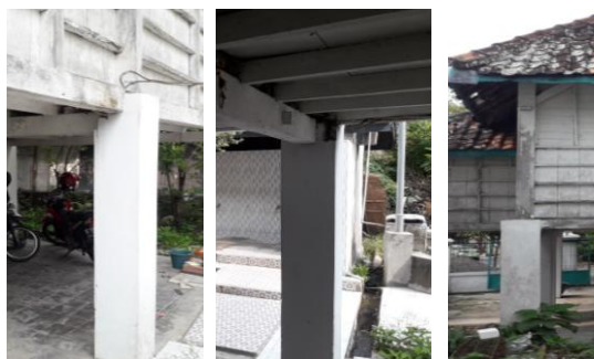
Gambar 9. Kolom Beton dan Tiang Kayu
