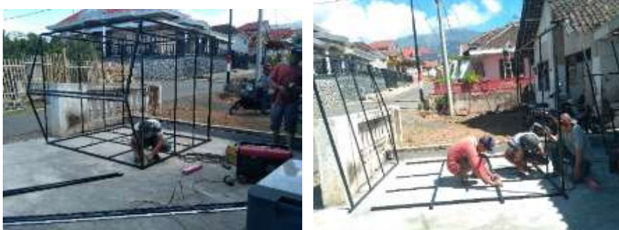
Gambar 1 dan 2 Perakitan Kerangka Pengereng
