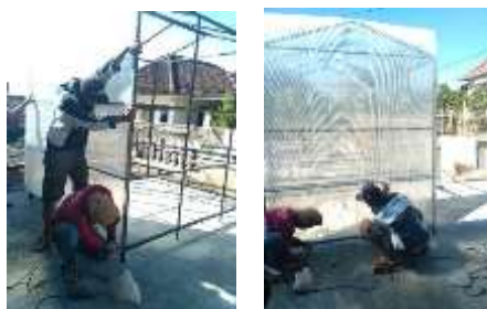
Gambar 3 dan 4 Pemasangan Atap dan Dinding Pengering
